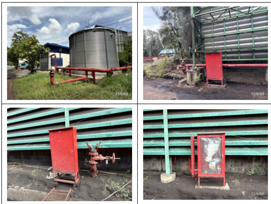
รูปที่ 1.5-2 : การติดตั้งอุปกรณ์แจ้งเตือนและระงับอัคคีภัย
